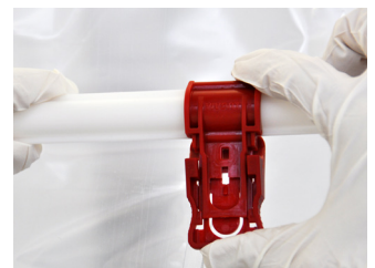
Die Sicherungsklemme schliessen.
